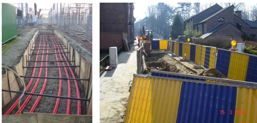
Figuur 36: Foto kabelsleuf
