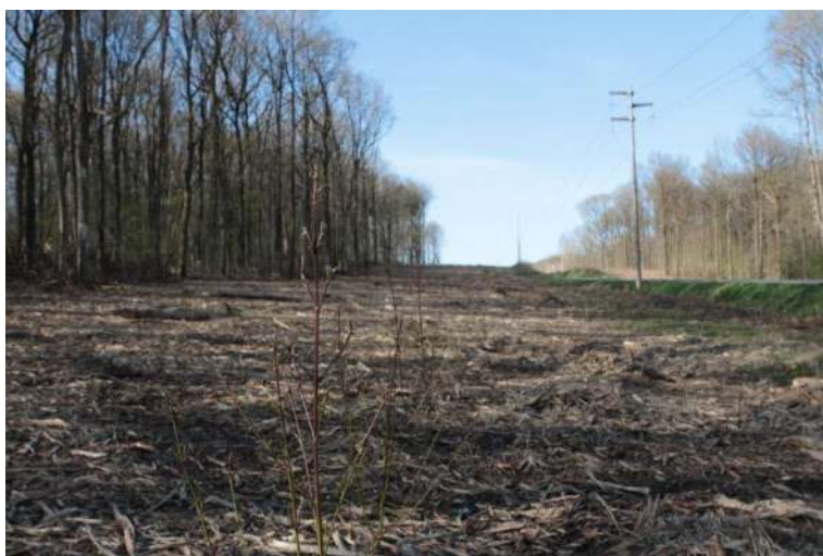
Action LIFE : travaux (le 2015-04-15)
