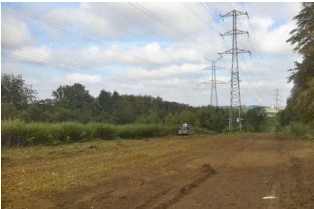
Action LIFE : travaux (le 2014-09-15)
