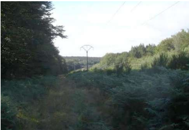
Etat initial avant travaux (le 2011-08-05)
