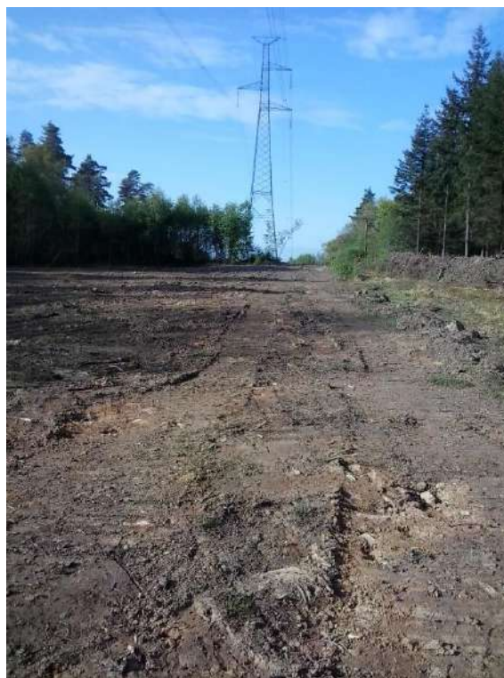
Action LIFE : travaux (le 2014-04-22)
