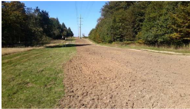
Action LIFE : travaux (le 2015-10-01)
