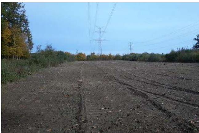
Action LIFE : travaux (le 2015-10-12)
