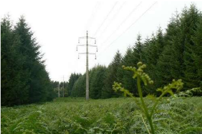
Etat initial avant travaux (le 2009-07-27)
