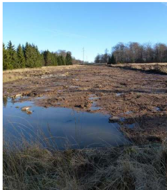
Action LIFE : travaux (le 2013-12-10)
