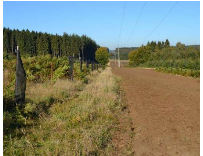
Action LIFE : travaux (le 2015-10-02)
