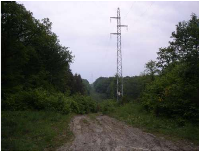
Etat initial avant travaux (le 2011-05-10)
