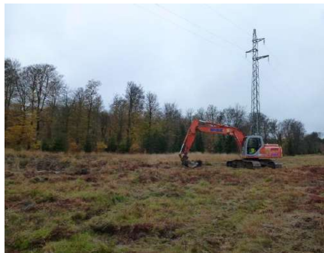
Action LIFE : travaux (le 2013-11-07)
