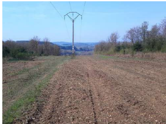
Action LIFE : travaux (le 2016-05-02)
