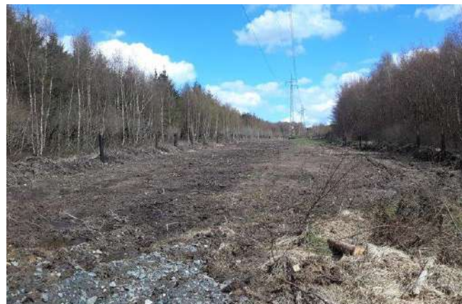
Action LIFE : travaux (le 2016-04-15)
