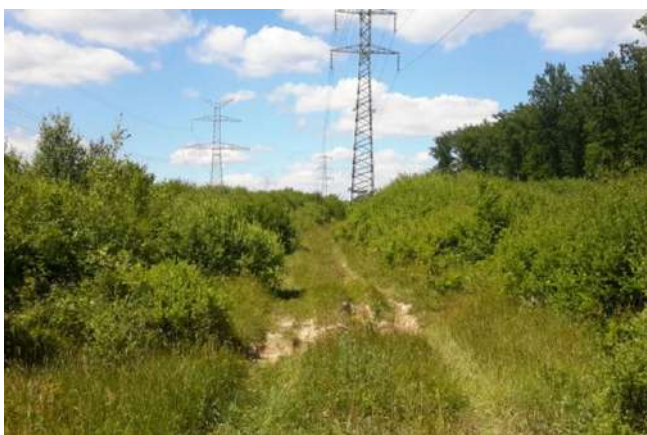
Etat initial avant travaux (le 2014-06-25)
