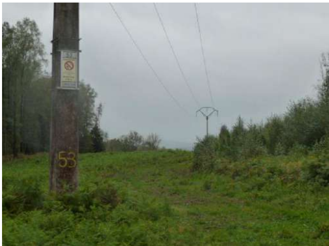
Etat initial avant travaux (le 2012-10-05)
