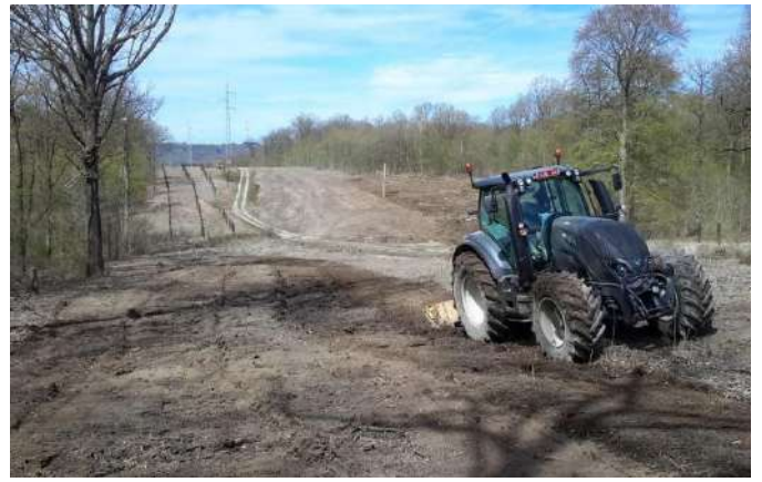
Action LIFE : travaux (le 2016-04-21)
