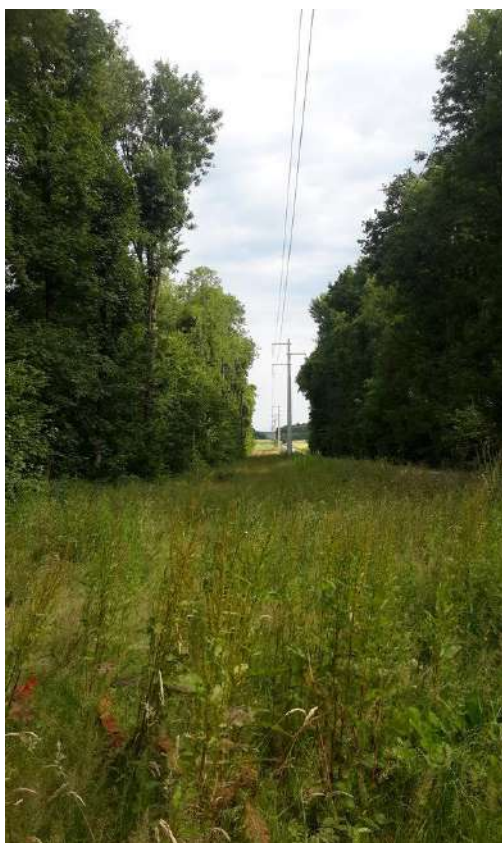
Etat initial avant travaux (le 2014-07-04)
