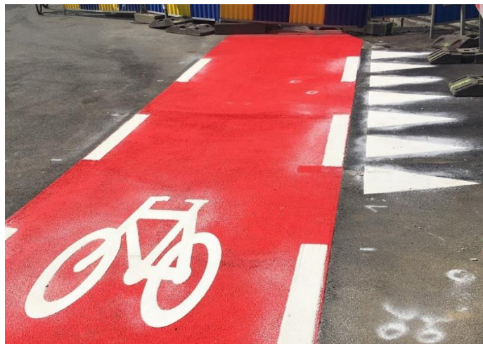
Figuur 1.9: Fietspad aangelegd na kabelwerken
