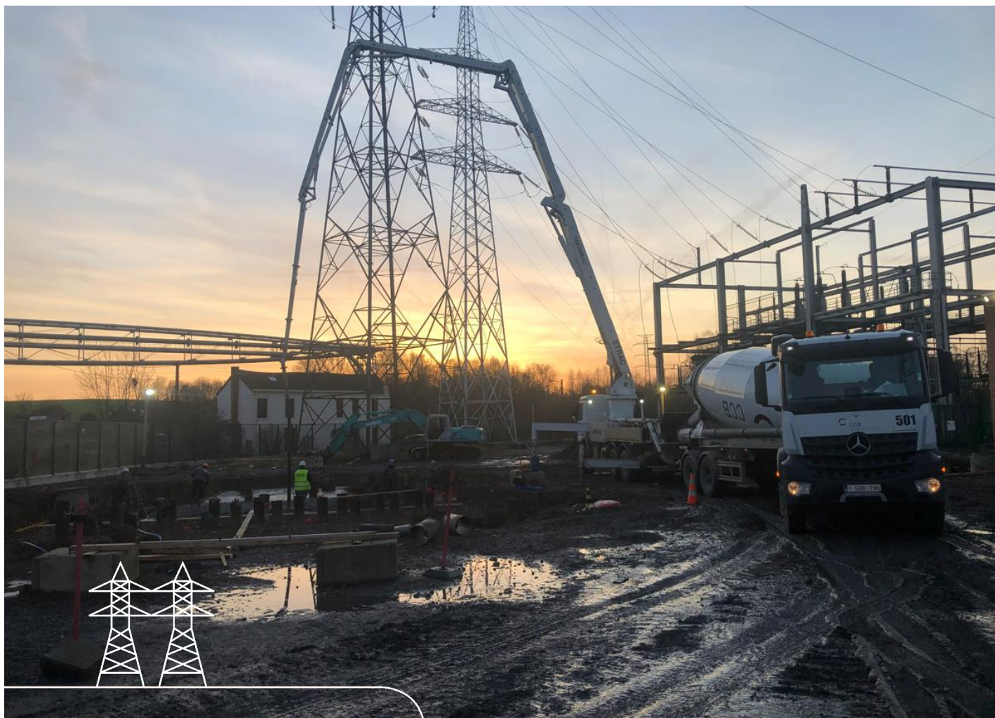
Chantier à Ville-sur-Haine (cuve nouveau transformateur)
