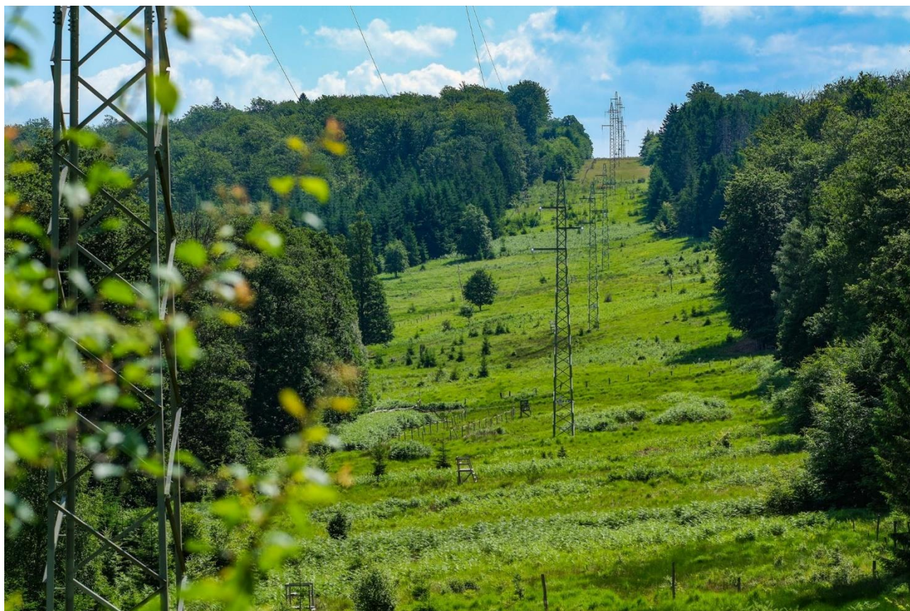
Figure 2.15: Site du projet Life Elia à Nassogne, corridor de la ligne 70.333 entre Forrières et Herbaimont
