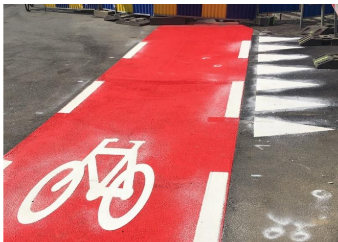
Figuur 1.9: Fietspad hersteld na kabelwerken
