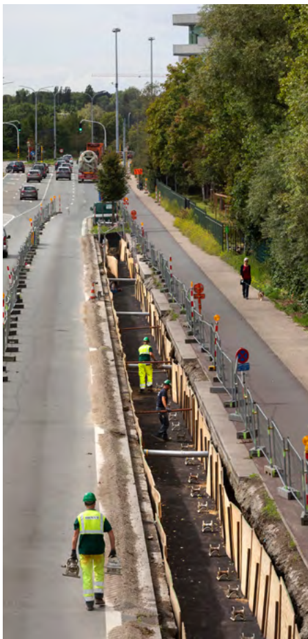
Construction d'une liaison souterraine
