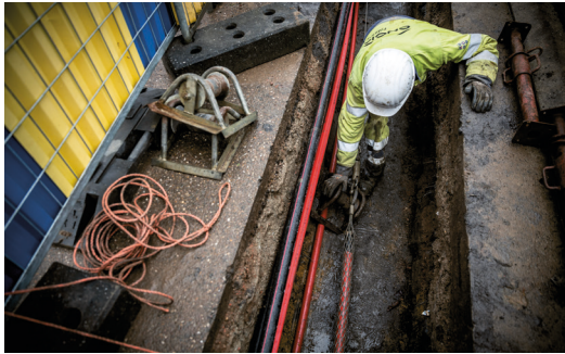
Pose d'une liaison de 36 kV dans un quartier résidentiel.
