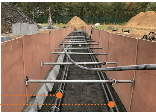
Pose d'une double liaison de 150 kV.
