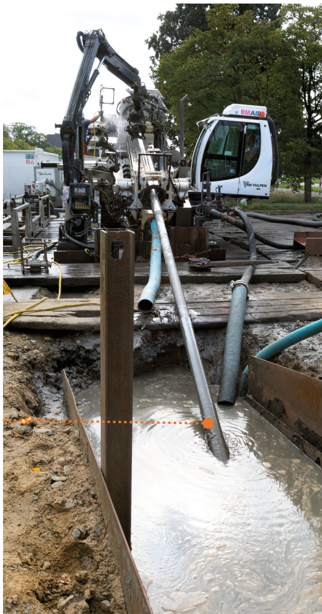
Forage dirigé pour un câble de 150 kV.
