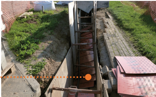
Pose d'une liaison de 70 kV après installation de plaques de protection et d'un ruban avertisseur.
