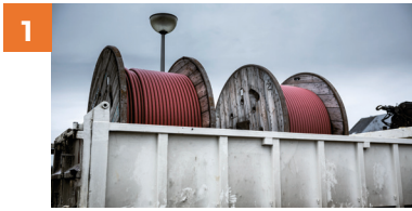
1 Het transport van de kabels gebeurt op bobijnen.
