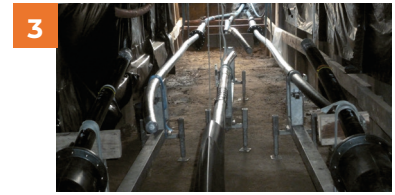
3 Binnen in de mofput van een 70kV-kabel.
