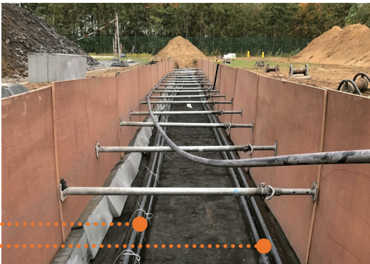
Aanleg dubbele 150kV-verbinding.
