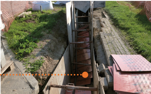
Aanleg 70kV-verbinding na plaatsing beschermingsplaten en waarschuwingslint.
