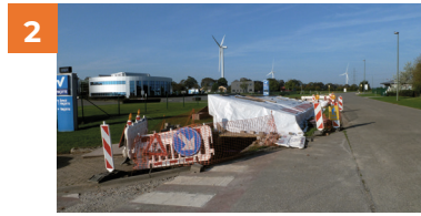
2 De mofput van een 70kV-kabel.
