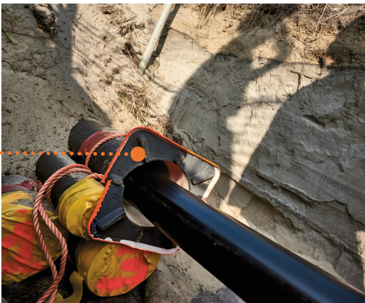
Wachtbuizen voor een dubbele 150kV-verbinding.
