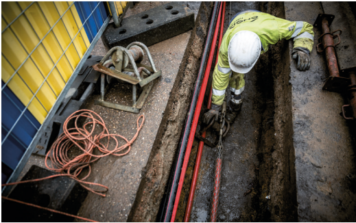
Aanleg 36kV-verbinding door een woonwijk.
