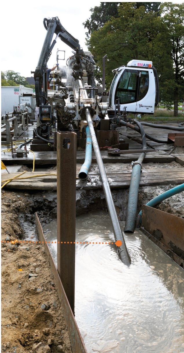
Gestuurde boring bij een 150kV-kabel.
