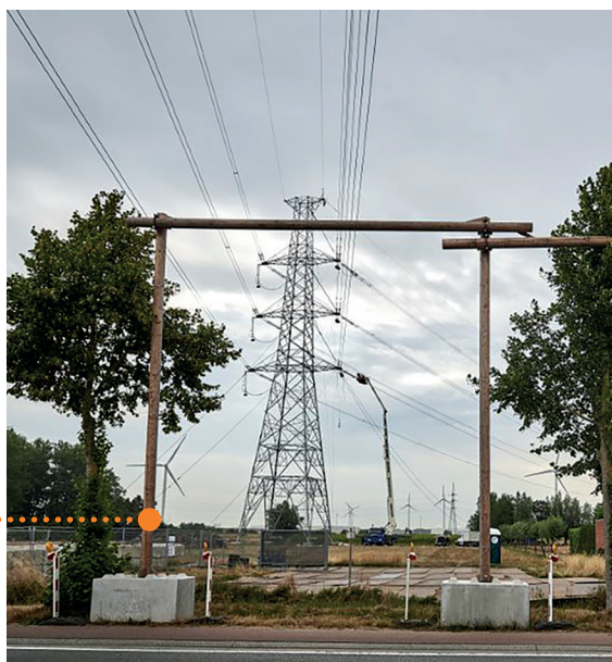
Exemple d'installation de deux portiques en bois sous une liaison aérienne.
