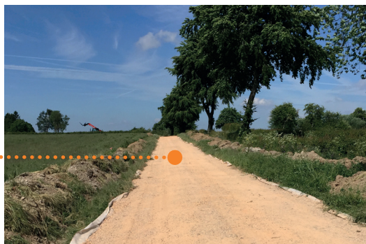
..... Een toegangsweg in steenslag.
