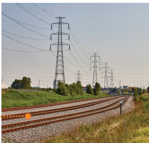
Hoogspanningslijn Brabo loopt langs de spoorlijnen in de Antwerpse haven.
