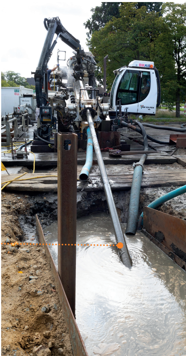
Gestuurde boring bij een 150kV-kabel.
