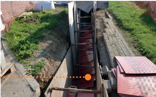
Aanleg 70kV-verbinding na plaatsing beschermingsplaten en waarschuwingslint.
