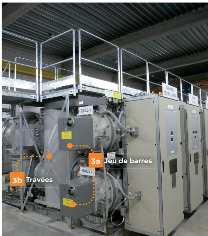
Intérieur d'un bâtiment GIS avec appareillage de commutation
