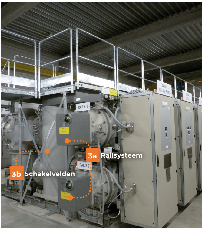
Binnenkant GIS-gebouw met schakelapparatuur
