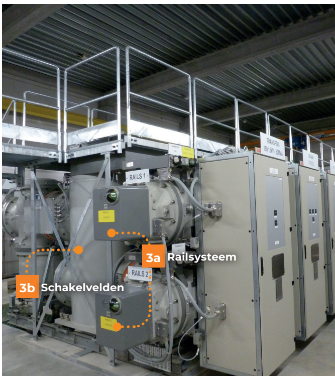
Binnenkant GIS-gebouw met schakelapparatuur
