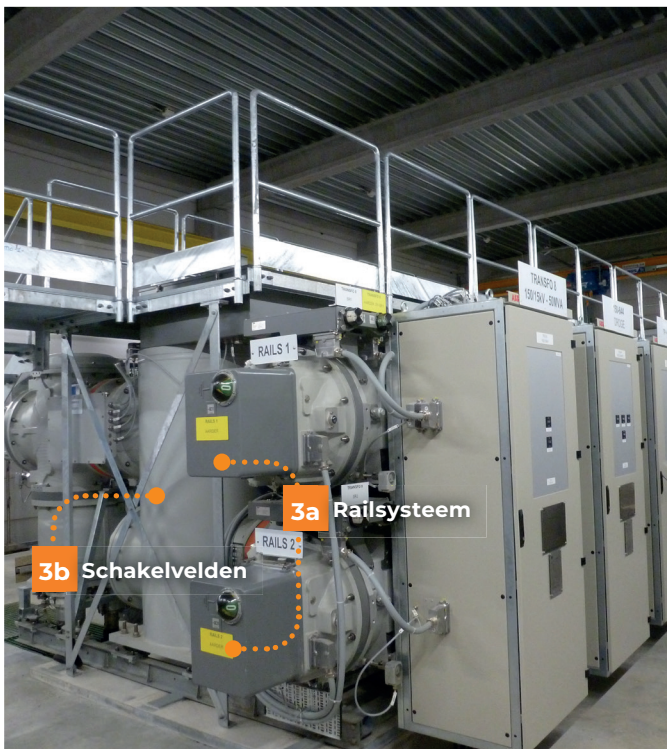
Binnenkant GIS-gebouw met schakelapparatuur
