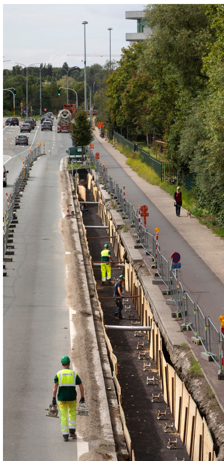
Construction d'une liaison souterraine
