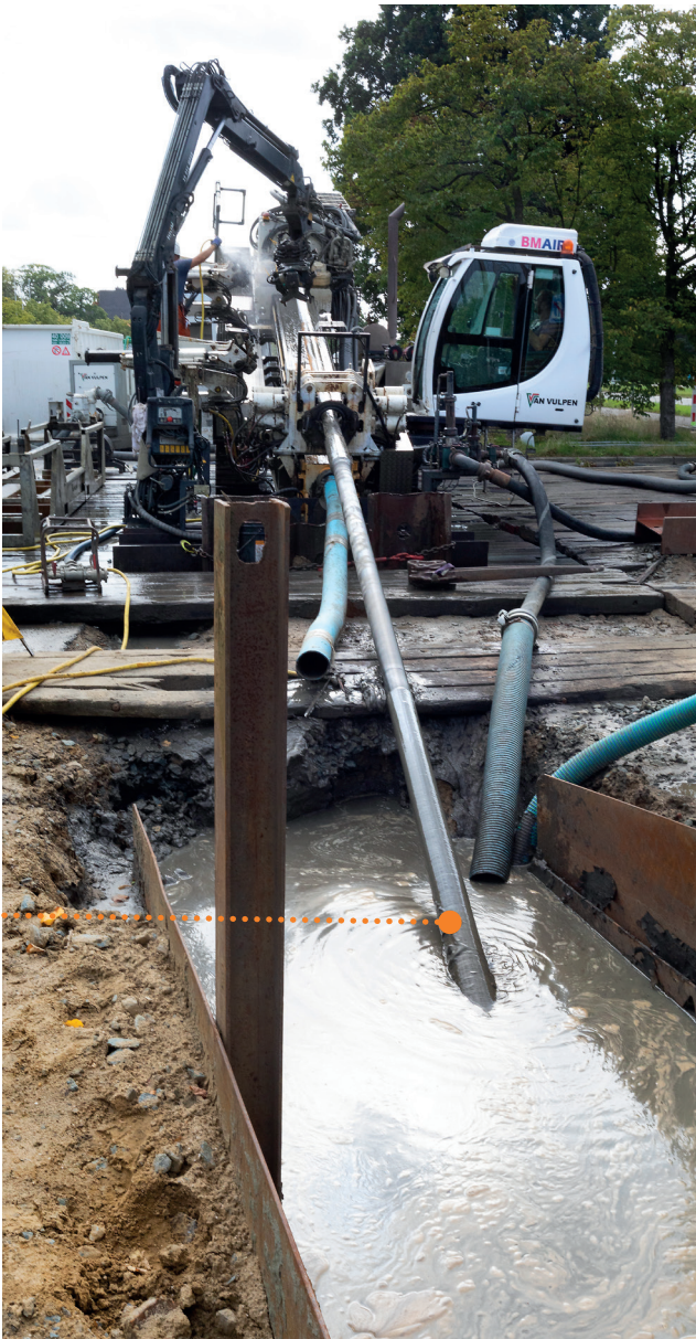
Gestuurde boring bij een 150kV-kabel.
