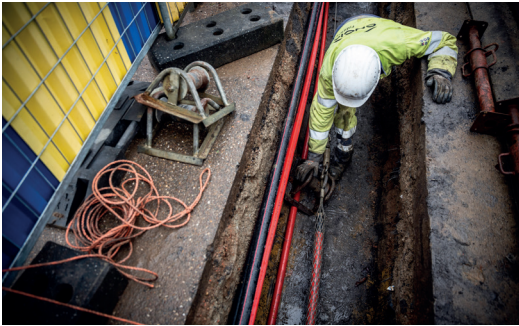
Aanleg 36kV-verbinding door een woonwijk.
