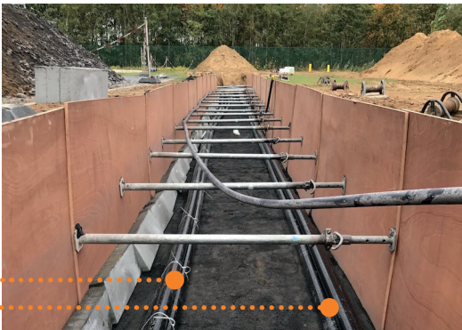
Aanleg dubbele 150kV-verbinding .
