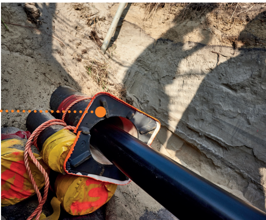
Wachtbuizen voor een dubbele 150kV-verbinding.
