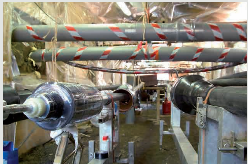
De verbindingen tussen de kabelgedeelten zijn vereist om de 500 tot 800 m.
