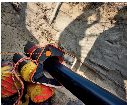
Wachtbuizen voor een dubbele 150kV-verbinding.
