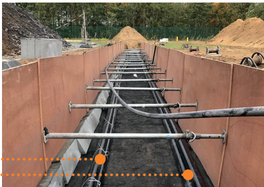
Aanleg dubbele 150kV-verbinding .
