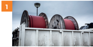
1 Het transport van de kabels gebeurt op bobijnen.
