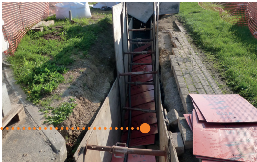
Aanleg 70kV-verbinding na plaatsing beschermingsplaten en waarschuwingslint.
