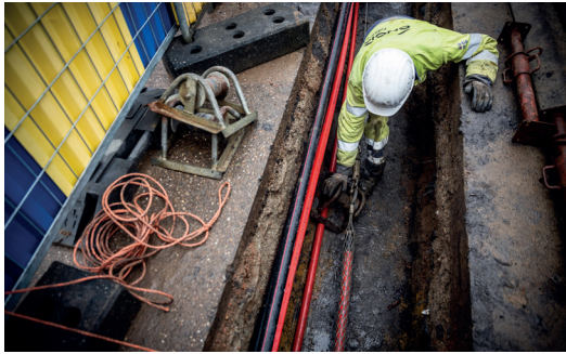
Aanleg 36kV-verbinding door een woonwijk.
