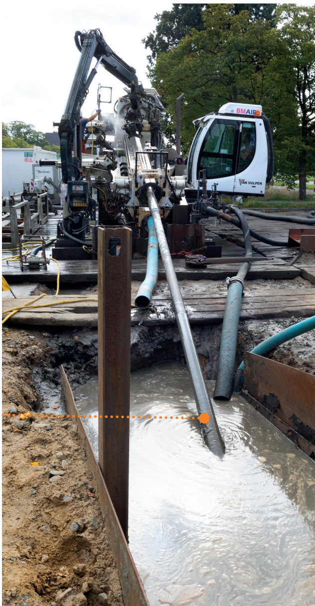
Gestuurde boring bij een 150kV-kabel.
