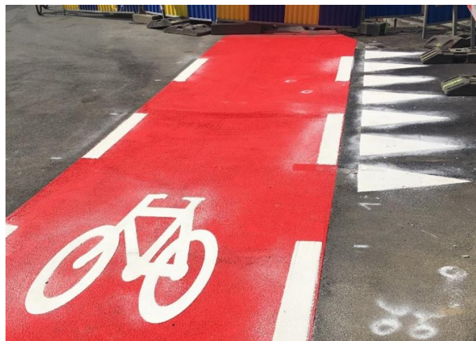
Figuur 1.9: Fietspad hersteld na kabelwerken
