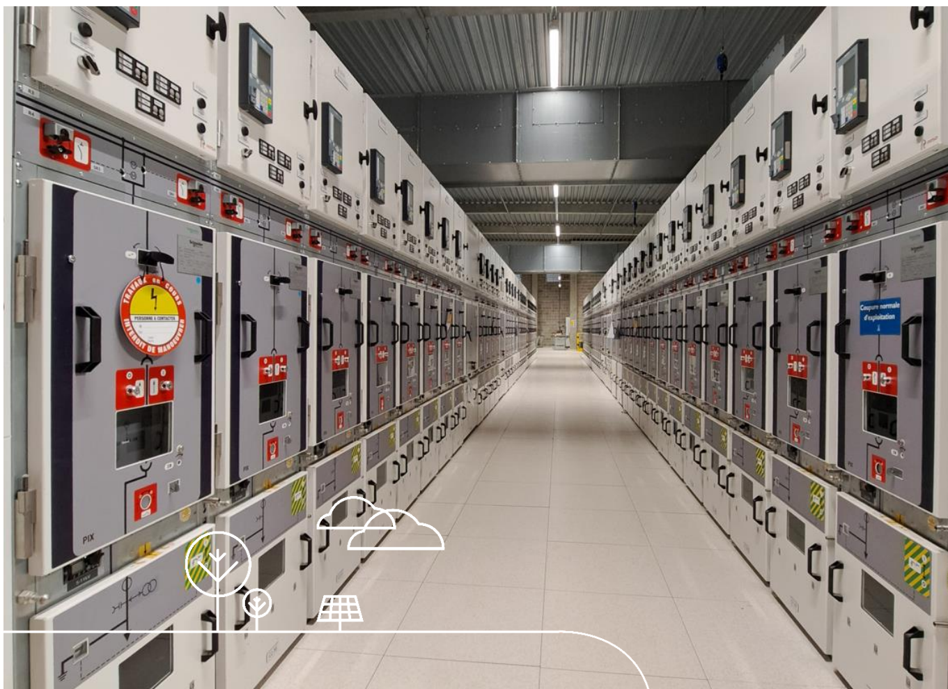
Projet d'Angleur (rénovation de la cabine 6 kV)
