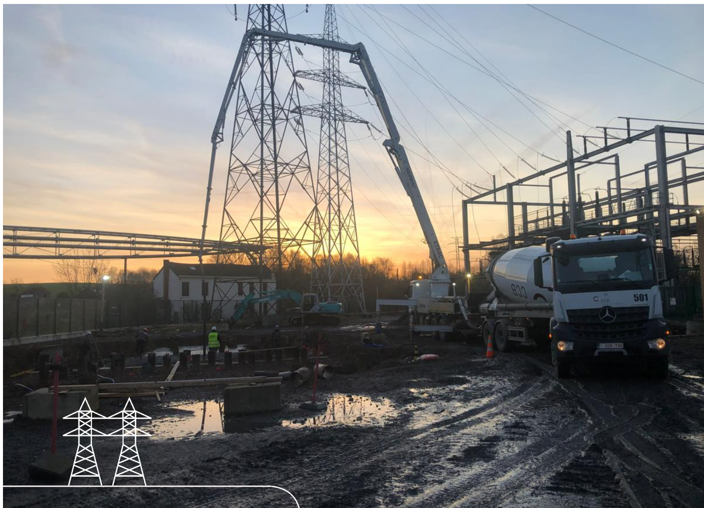
Chantier à Ville-sur-Haine (cuve nouveau transformateur)
