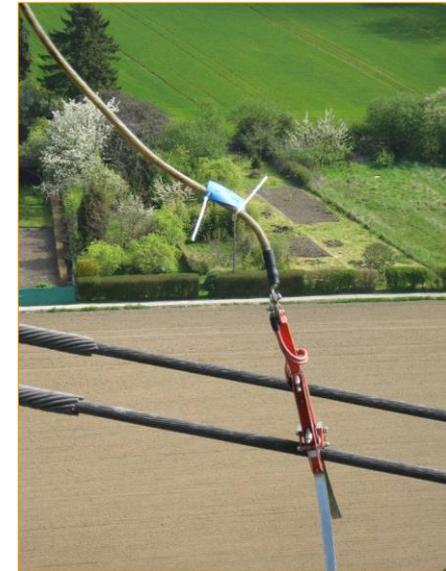
La tension d'induction s'annule par la mise à la terre de l'engin
