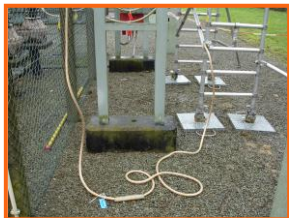
← Losse inductieaarding (bv. 95 mm 2 Cu)
