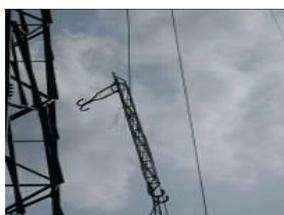
Par exemple une échelle à crochets est hissée sur un pylône par 2 personnes au sol et une se trouvant sur une des consoles du pylône. Au sol, une personne hisse et l'autre qui à l'aide d'une deuxième corde arrimée également à l'échelle l'écarte du pylône afin d'éviter que l'échelle ne s'accroche sur la structure du pylône.
