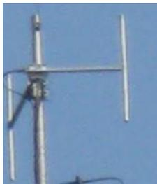
Ces antennes ont la forme d'un long tube métallique, généralement entre 1 et 3 mètres de haut. Ces antennes sont moins utilisées. Elles sont plutôt installées sur les pylônes RF (presque pas sur les pylônes HT). Le volume en dehors de la zone à risque (voir ci-dessous) ne représente pas un risque pour la santé des travailleurs.
