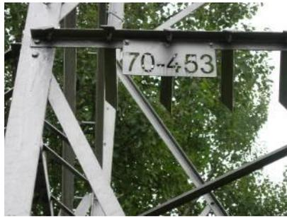
Le terne est toujours identifié sur le pylône, au moyen d'une numérotation se trouvant sur la plaque de terne. Cette plaque d'identification se trouve à la base du fût du pylône. Dans le cas de pylônes à ternes multiples, chaque plaque est placée de telle manière à identifier la position réelle du terne associé. Cette numérotation comprend le niveau de tension de la ligne suivi du numéro unique du terne attribué par Elia (par exemple: 70-453, 150-201, 380-60). Voir note d'application 04.59.
