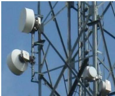
Ces antennes ont un diamètre variant entre 30 et 240 cm et elles sont généralement protégées par une enveloppe cylindrique ou conique. Le volume en dehors de la zone à risque (voir ci-dessous) ne présente pas de danger pour la santé des travailleurs.
