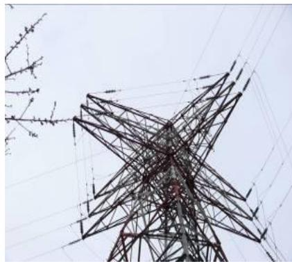
Dans le cas de pylônes présentant une configuration de ternes complexe où il est difficile de repérer au moyen de ces seules plaques, le monteur de lignes devra alors disposer de données de configuration plus précises (dans l'IPSL instructions particulières de sécurité lors des travaux sur les lignes à haute tension). L'ordre des phases (par exemple : 4-8-12) peut parfois être encore indiqué sur la même plaque, mais est voué à disparaître.
