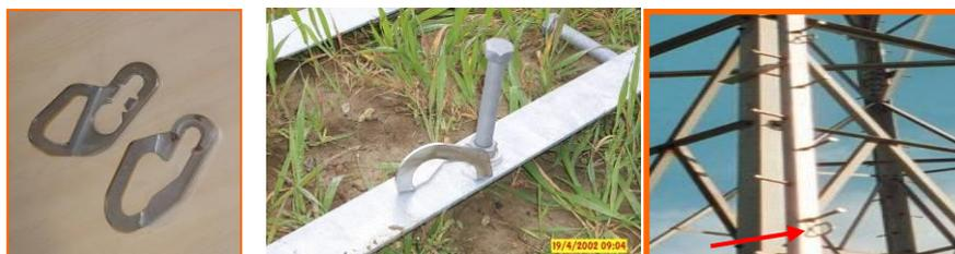
Les points d'ancrage servent à s'accrocher au pylône via les mousquetons et la longe en Y. Lors de chaque escalade l'état de chaque point d'ancrage doit être contrôlé par celui qui monte.
