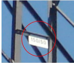
Sur la plupart des pylônes, les limites de sécurité sont matérialisées par des plaques limites de sécurité identiques aux plaques de ternes qui se trouvent à la base du fût du pylône ou en leur absence par des drapeaux lors des travaux. Voir note d'application 04.59.
