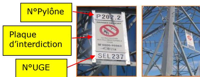
C'est l'ensemble de trois plaques, à savoir le numéro de pylône, la plaque d'interdiction et le numéro d'unité géographique (UGE). Pour les dimensions et l'installation des plaques voir (Note d'application 04.50). La combinaison du n° de pylône et du n° UGE permet d'identifier le pylône de façon univoque.
