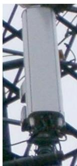
Ces antennes ont la forme d'un long panneau de 1 à 3m de haut et de 10 à 30cm de large. Le volume situé à l'arrière se trouve en dehors du gabarit de sécurité (voir ci-dessous) et ne représente pas de danger pour la santé des travailleurs.
