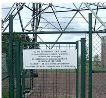
**Exception pour les antennes des stations radio-FM** (situées uniquement au sommet de quelques pylônes RF. Exemples : VRT, 4FM, Broadcast Partners,...). Ces antennes ont une puissance d'émission élevées (1000W). Il est important de demander une réduction de la puissance d'émission des antennes, pendant toute la durée des interventions située au même niveau de l'antenne. La procédure pour ces exceptions est affichée sur le site même (voir photo ci-contre).
