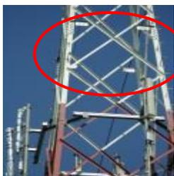
Comme on travaille en dessous de la limite de sécurité, il n'est pas obligatoire de mettre le(s) terne(s) hors tension. Ces plaques constituent la limite supérieure à ne pas dépasser. En cas d'absence de ces plaques, des drapeaux rouges seront placés.
