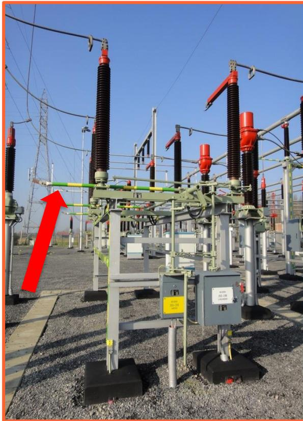
Sectionneur de mise à la terre mécanique (SAT)
