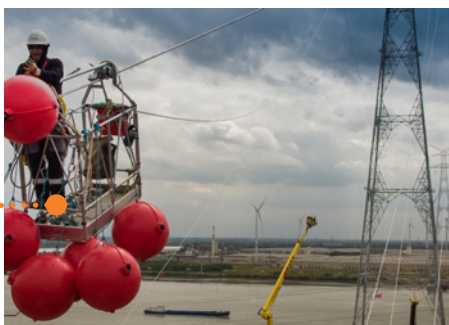
Via een gondel worden bakens geplaatst.
