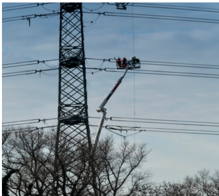
Medewerkers van Elia plaatsen bakens met een hoogtewerker.
