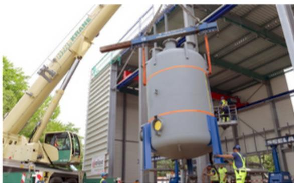
Les deux grandes chaudières électriques du projet Power-to-Heat (P2H) entre Hamburger Energiewerke et 50Hertz ont été installées avec succès. Fin 2022, le système P2H devrait doter environ 27 000 appartements de chauffage urbain vert. Le système transforme l'électricité en chaleur lorsque le volume d'énergie éolienne est important et que le réseau fait face à des congestions. 50Hertz finance la centrale de 80 MW à hauteur de 31,5 millions d'euros.
