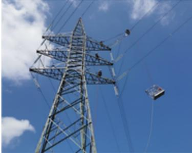
Grâce aux balises, la probabilité qu'ils percutent la ligne est bien plus faible. Au total, Elia installe 300 balises en forme de spirale et 11 sphères de balisage rouges et blanches sur la ligne ainsi que 3 balises lumineuses sur chacun des deux pylônes de part et d'autre de l'autoroute E42.
